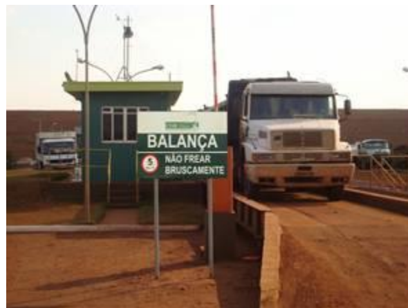
Figura 100. Balança rodoviária na entrada do aterro sanitário
