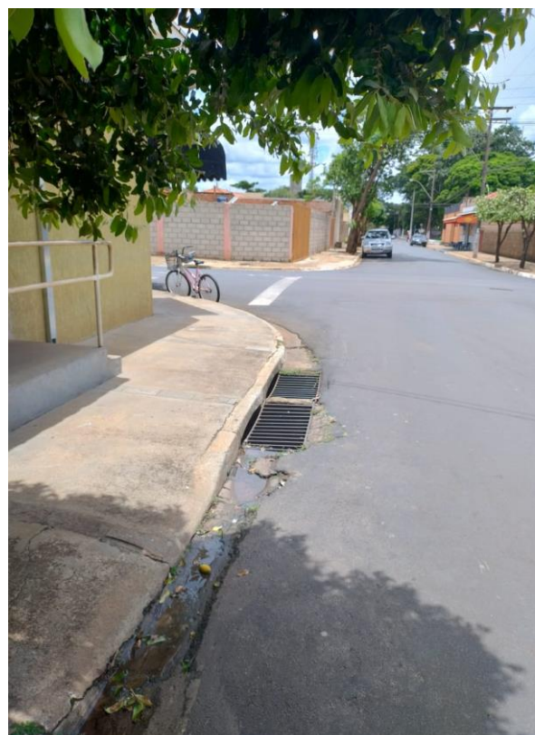
Figura 130. Boca de lobo localizada no cruzamento da Rua dos Oleandros com a Rua das Sibipirunas
