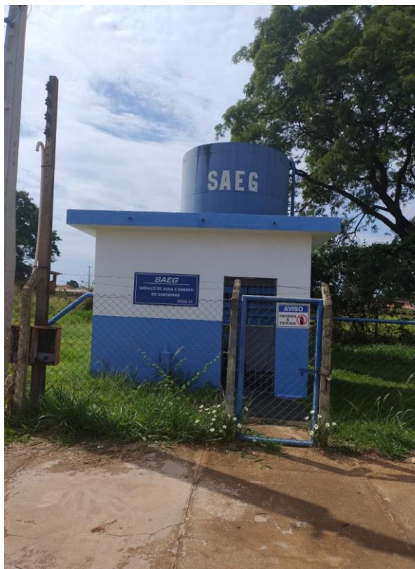
Figura 33. Vista geral da entrada do local do Poço P3.
