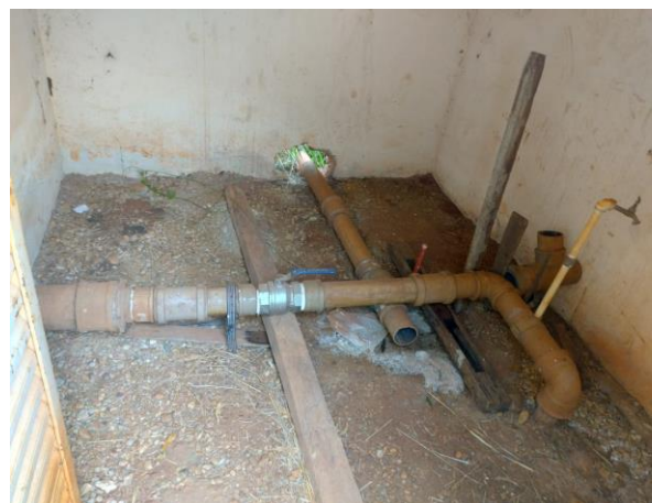
Figura 57. Detalhe da tubulação de abastecimento da rede na saída do Reservatório R5.
