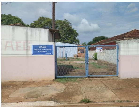
Figura 29. Vista geral do Poço P1
