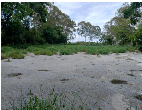
Figura 82. Vista geral da lagoa facultativa com chincanas
