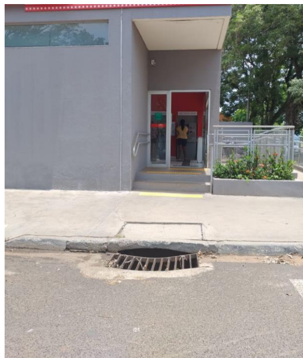
Figura 128. Boca de lobo localizada no cruzamento da Rua Hermínio Félix Bonfim Mínio com a Rua José Linares Neto
