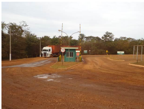
Figura 99. Vista da Entrada do Aterro Sanitário
