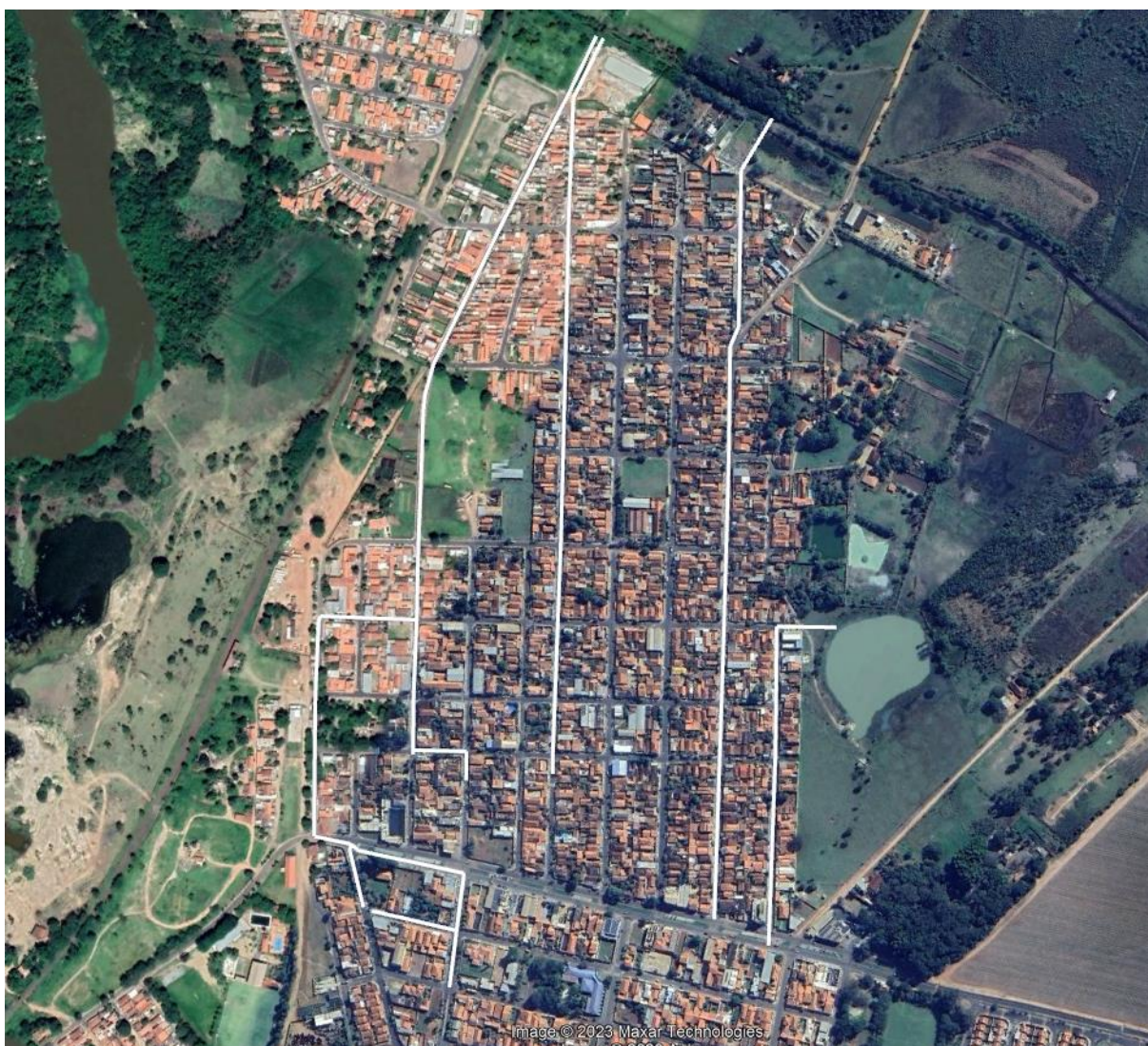
Figura 123. Principais redes de drenagem de guas pluviais urbanas nos bairros Centro e Maria Luiza.
