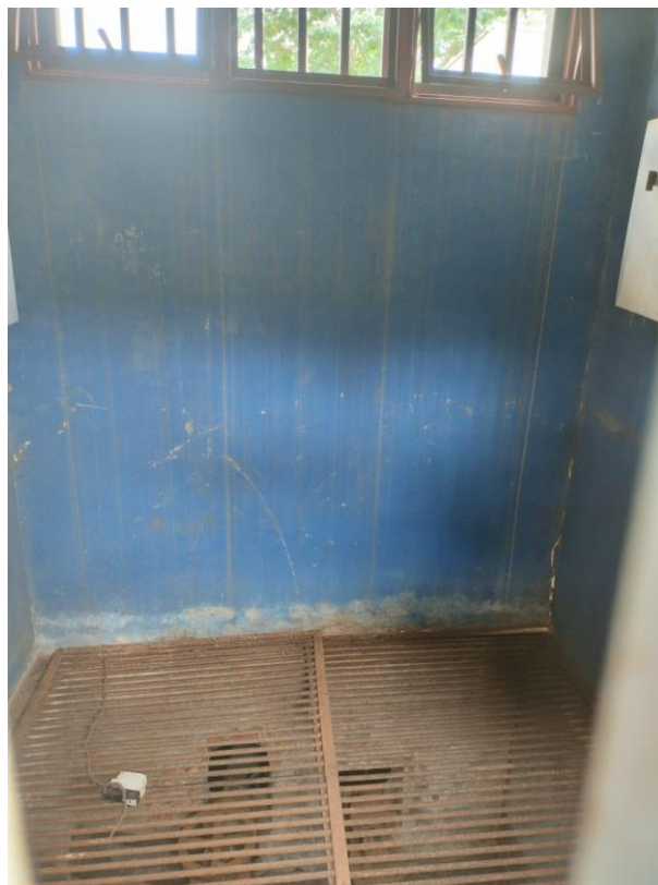
Figura 67. Detalhe dos registros de manobra da EEEB Centro Esportivo
