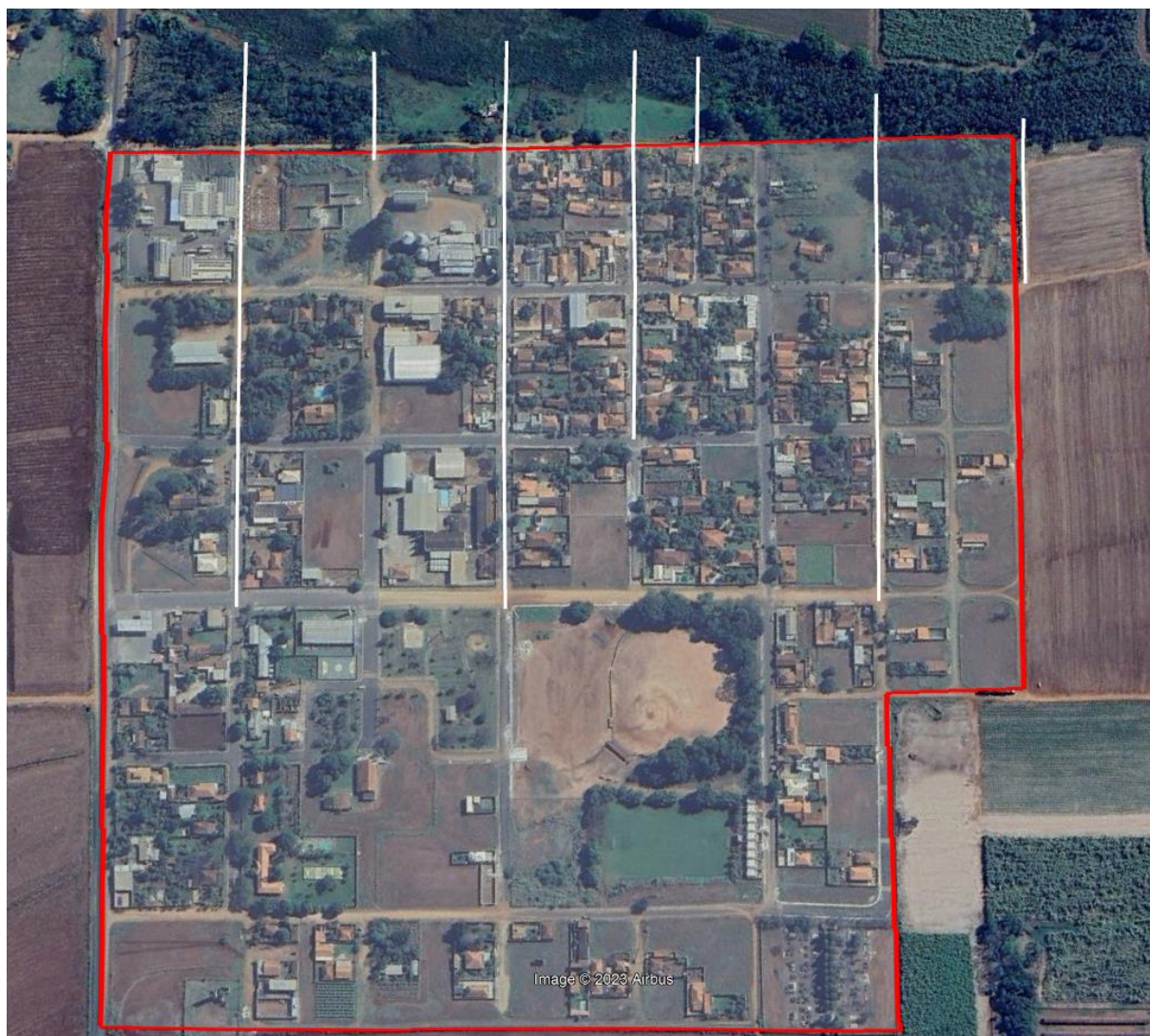
Figura 134. Principais redes de drenagem de guas pluviais urbanas no bairro da Mombuca.
