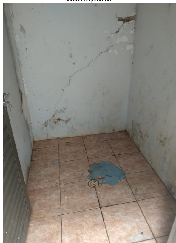
Figura 118. Local de acondicionamento dos RSS (Grupo D) na UBS Guatapar.
