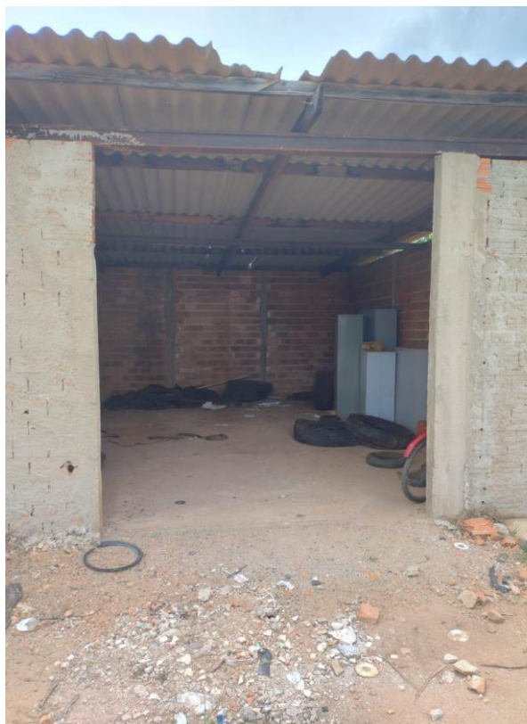
Figura 121. Área de transbordo de pneus no Departamento de Obras e Serviços
