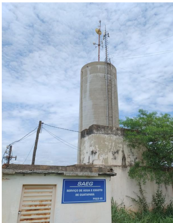
Figura 56. Vista geral do Reservatório R5.
