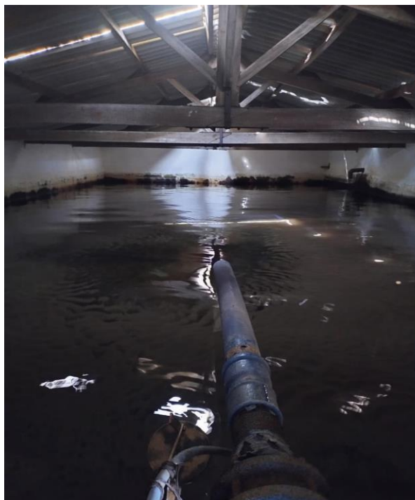
Figura 46. Vista geral do reservatório semienterrado de concreto R1.
