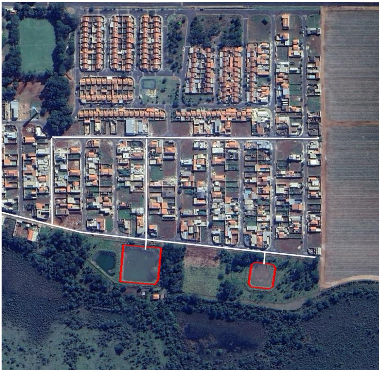
Figura 124. Principais redes de drenagem de águas pluviais urbanas nos bairros Jardim Alvorada e COHAB.
