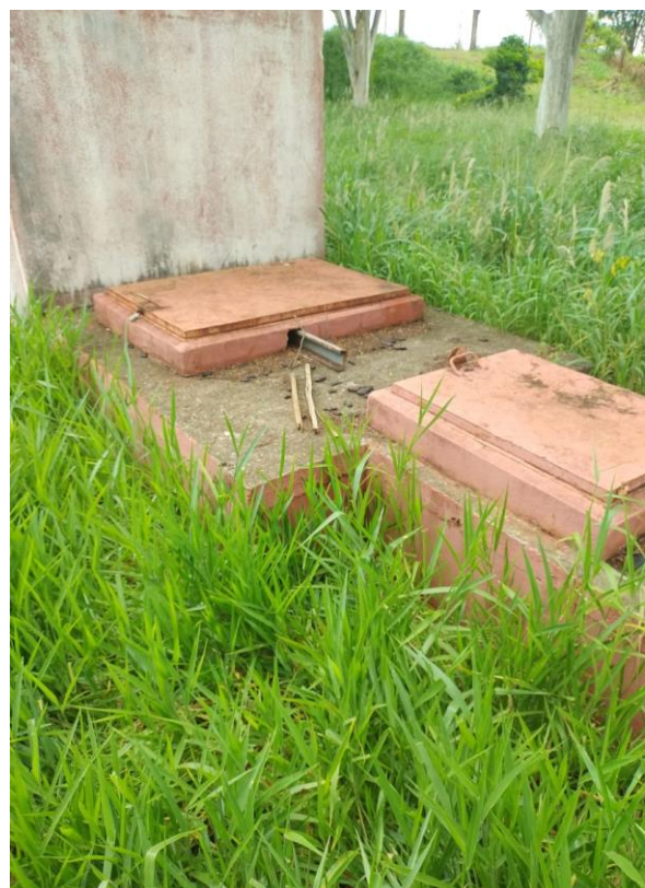
Figura 66. Vista geral da EEEB Centro Esportivo
