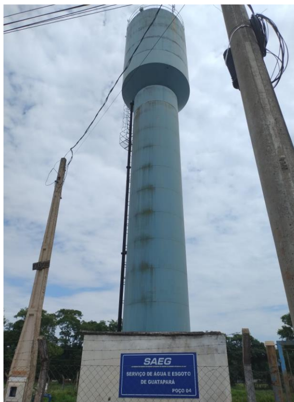
Figura 54. Vista geral do Reservatório R4
