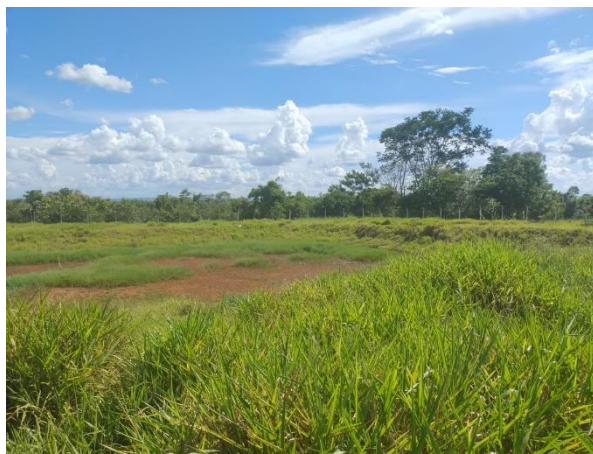
Figura 125. Vista da lagoa de retenção de águas pluviais 2, localizada na Rua José Aparecido Martins da Cruz
