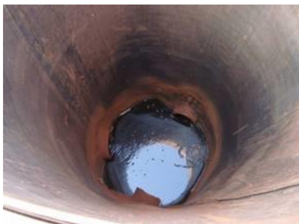
Figura 103. Sistema de captação de lixiviado
