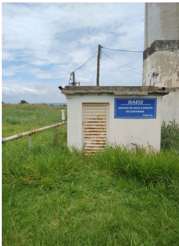
Figura 40. Vista geral do Poço P5.
