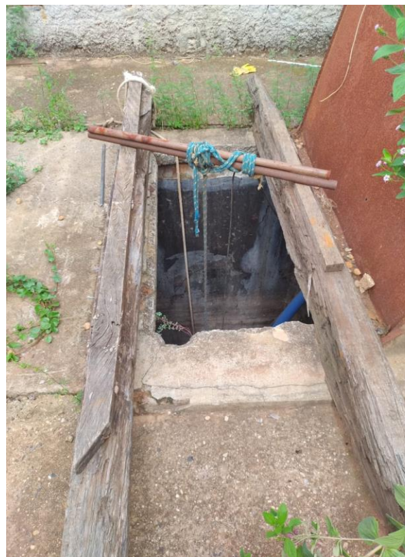
Figura 62. Detalhe do poço de sucção da EEBB COHAB
