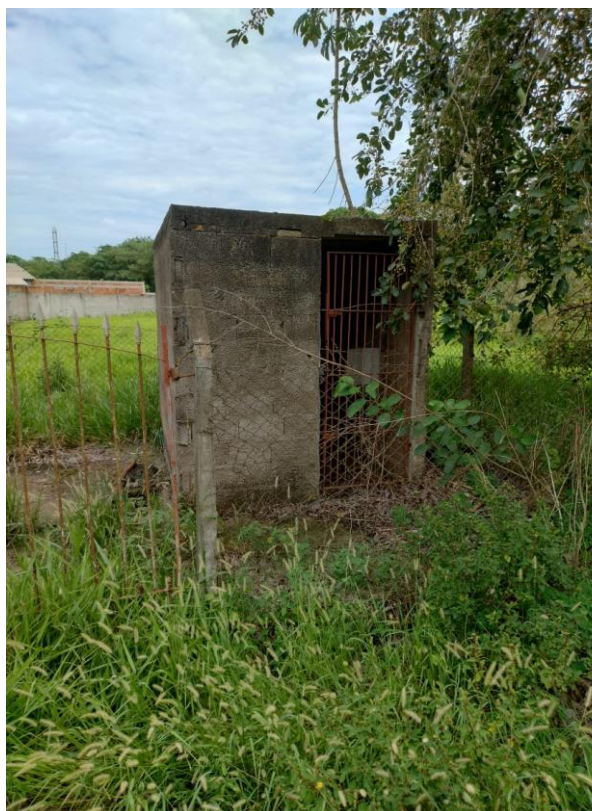
Figura 71. Vista geral da EEEB Maria Luiza.
