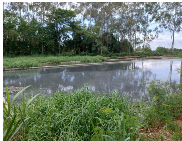
Figura 83. Detalhe da vista lateral das lagoas de tratamento
