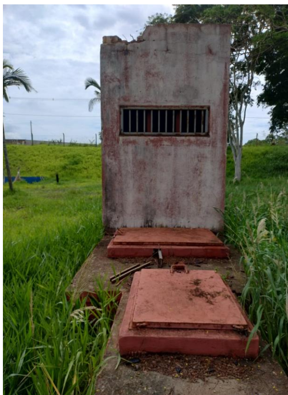
Figura 65. Vista geral da EEEB Centro Esportivo
