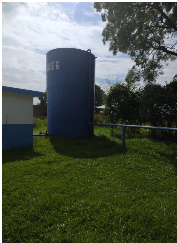
Figura 50. Vista geral do Reservatório R3.
