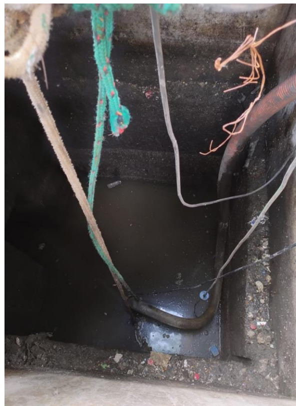
Figura 69. Detalhe do poço de sucção da EEBB Residencial Stella
