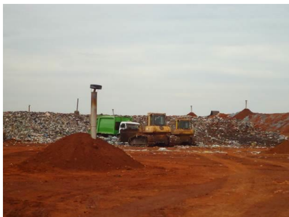
Figura 101. Compactação dos resíduos em camadas
