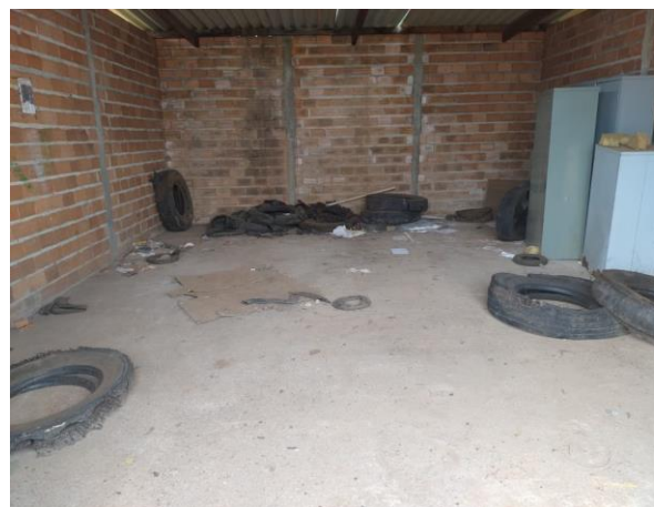
Figura 122. Detalhe da área de transbordo de pneus no Departamento de Obras e Serviços
