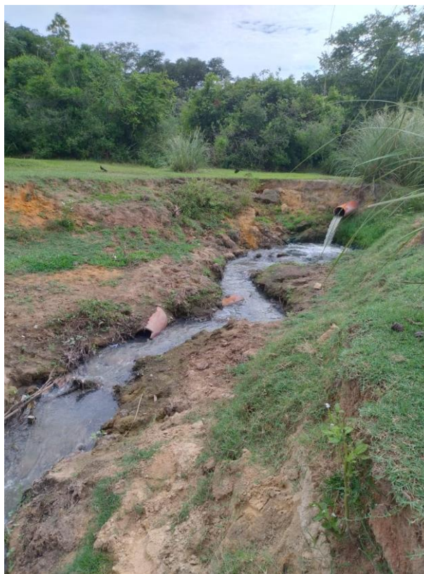
Figura 77. Detalhe do ponto de lançamento de esgoto bruto no Rio Mogi Guaçu
