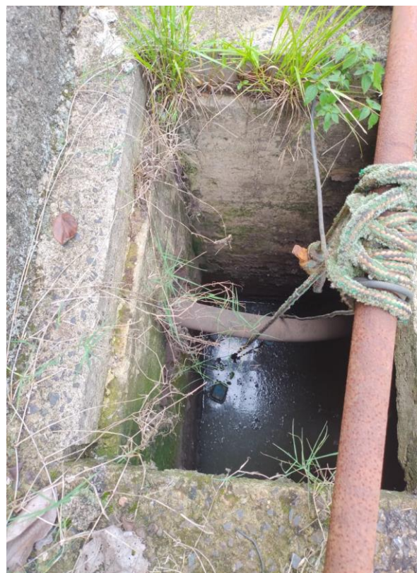
Figura 72. Vista do poço de sucção sem gradeamento da EEEB Maria Luiza.
