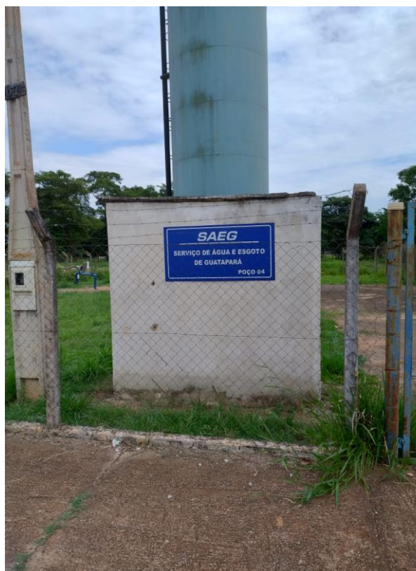
Figura 37. Vista geral da entrada do local do Poço P4.
