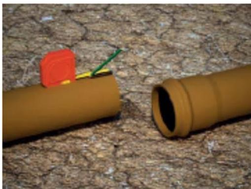
Marcar a profundidade da bolsa na ponta do tubo. Para o diâmetro da tubulação  $D = 100$  mm, considerar profundidade da bolsa de 85 mm.
