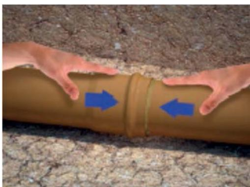
Encaixe da ponta chanfrada do tubo no fundo da bolsa, recuo 5 mm no caso de canalizações expostas e 2 mm para canalizações embutidas, tendo como referência a marca previamente feita na ponta do tubo. Esta folga se faz necessária para a dilatação da junta.
