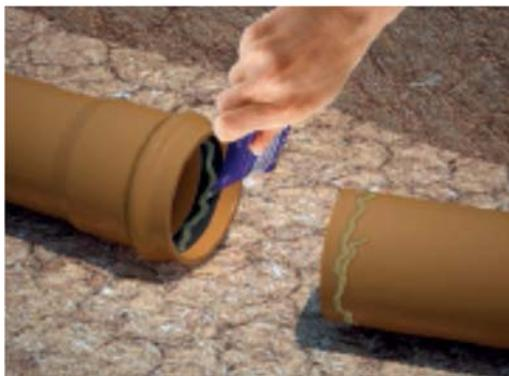
Aplicação da pasta lubrificante no anel e na ponta do tubo. Não usar óleo ou graxa, que poderão atacar o anel de borracha.
